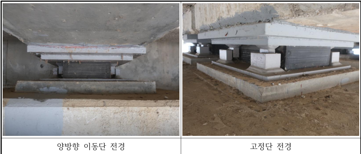
【그림 2.21】 북삼교 교량받침 현황
