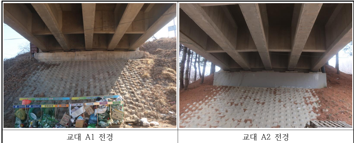
【그림 2.11】 북삼교 교대 전경
