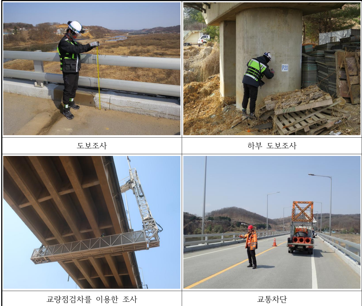
【그림 2.1】 북삼교 현장조사 전경
