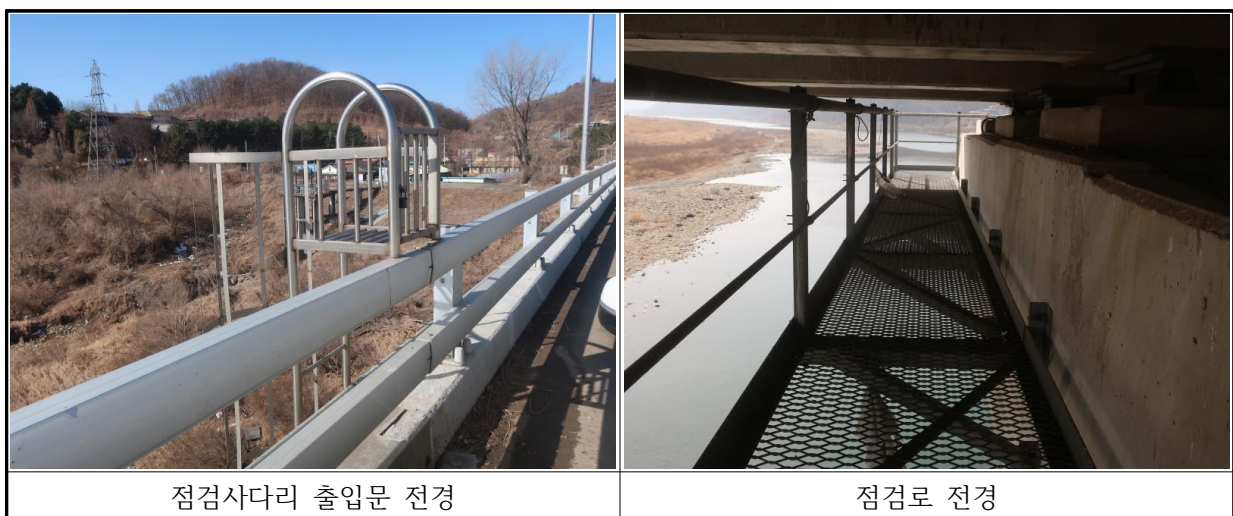
【그림 2.38】 북삼교 점검시설 전경
