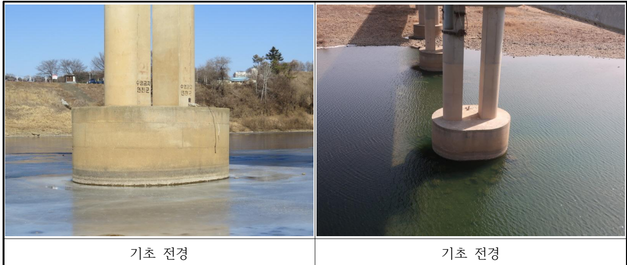
【그림 2.19】 북삼교 기초 전경
