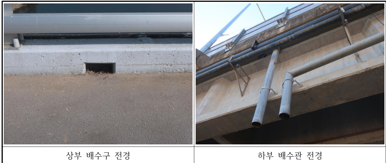
【그림 2.33】 북삼교 배수시설 현황
